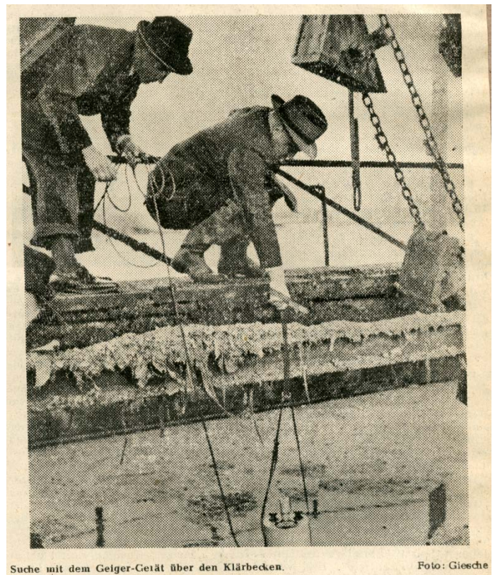
Suche mit dem Geiger-Getät über den Klärbecken.
